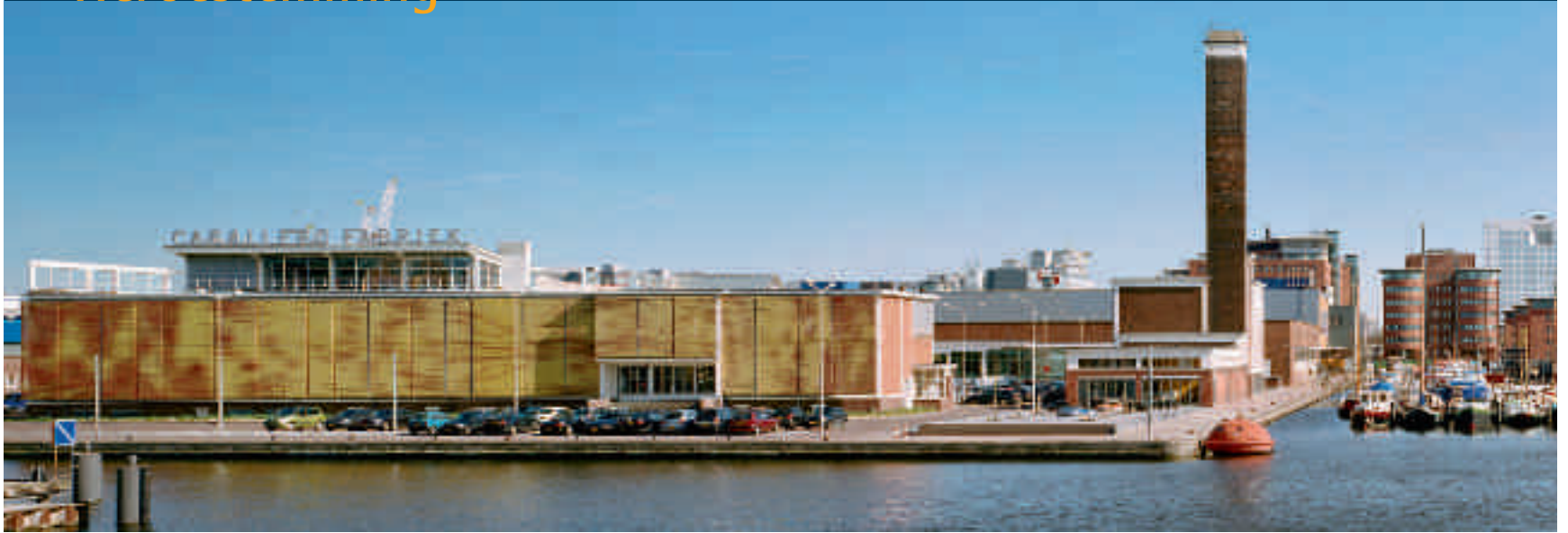
Voorgevel van de CabFab in Den Haag, met de 'doeken' die de kunststof kozijnen camoufleren.
